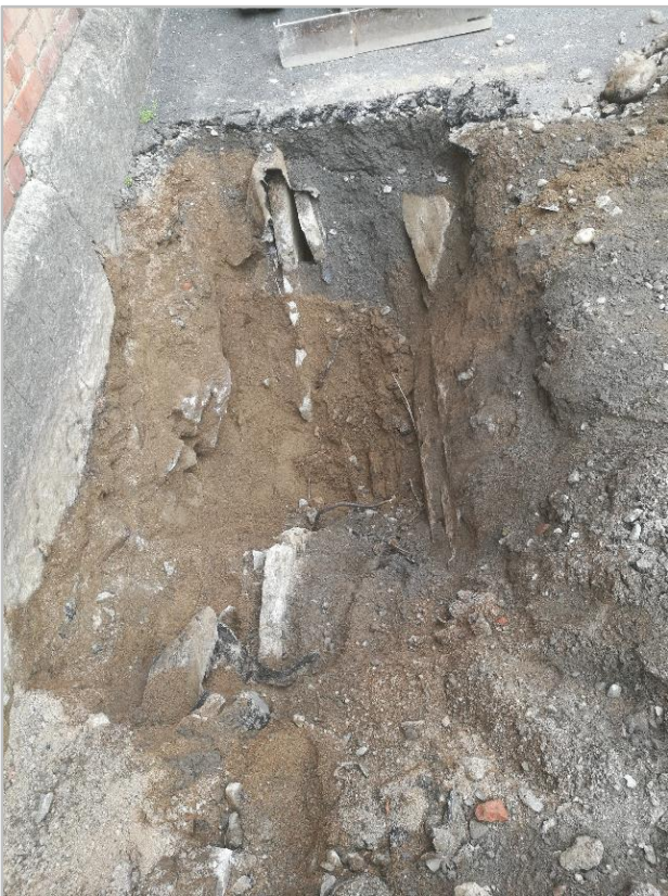
Kuva 7. KK4 betonirakenne vanha putkikanaali, pohja yli 1 metrin syvyydellä. Koekuopassa ei päästy syvemmälle. Sokkeli mahdollisesti kiviladonta.
