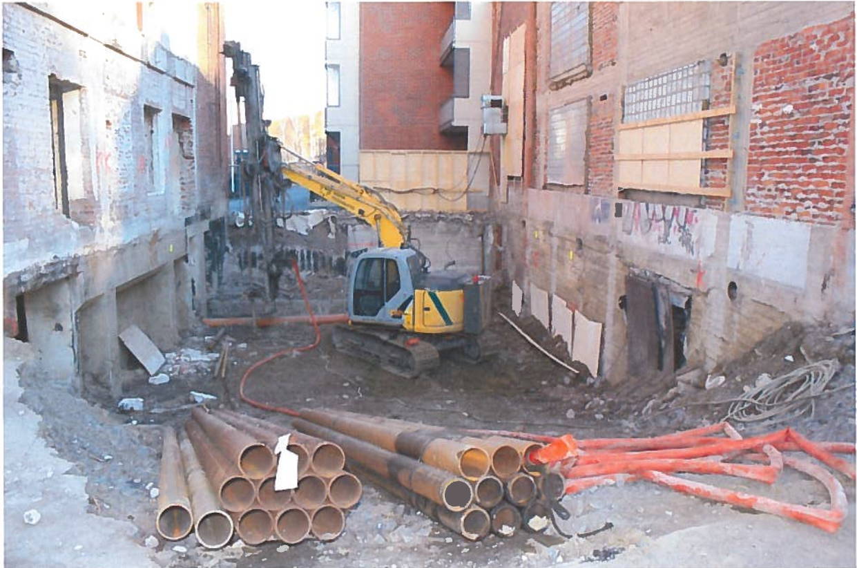
1 Voimalaitoksen laajennus purettiin
