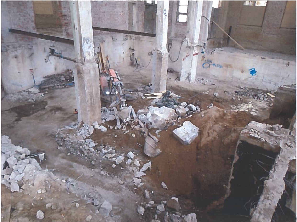
5 1. kerroksen alapohja purettu
