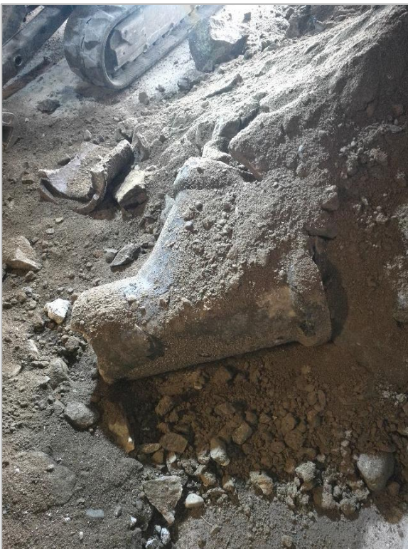
Kuva 9. KK5 noin 1 metrin syvyydessä Y-mallinen betonirakenne, mahdollisesti viemäri.
