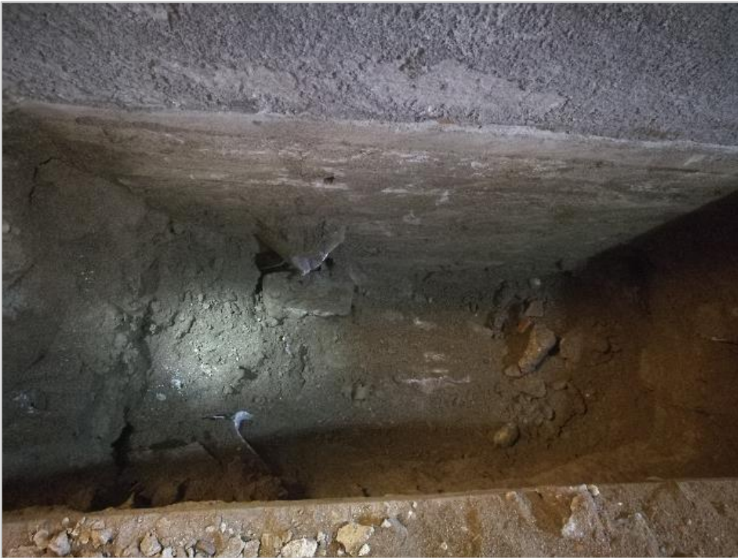
Kuva 10. KK5 pohjalla betonirakenne, mahdollisesti antura.
