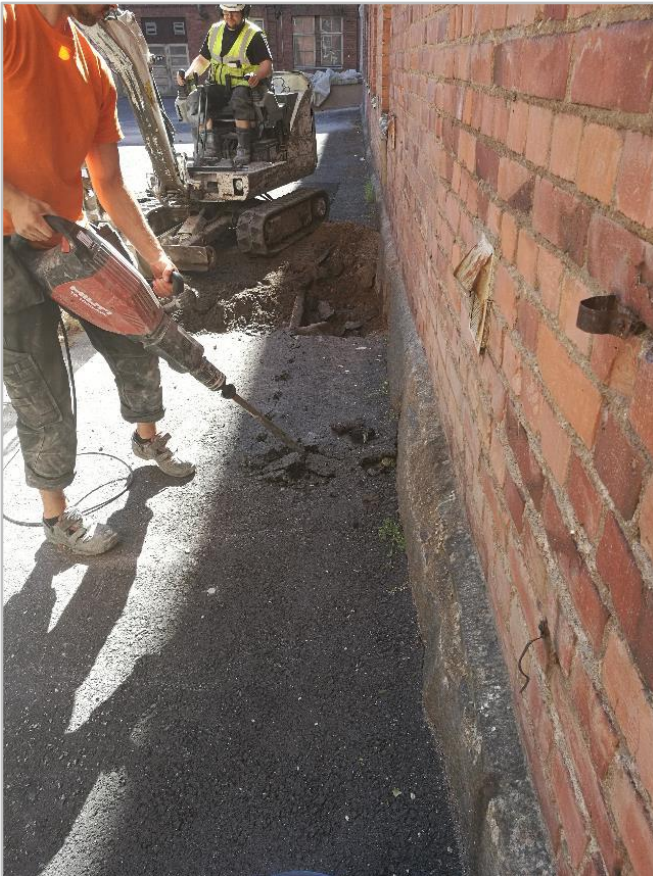
Kuva 6. Heti pinnassa betonirakenne, koekuoppaa siirrettiin, mutta rakenne jatkui seinän suuntaisesti.
