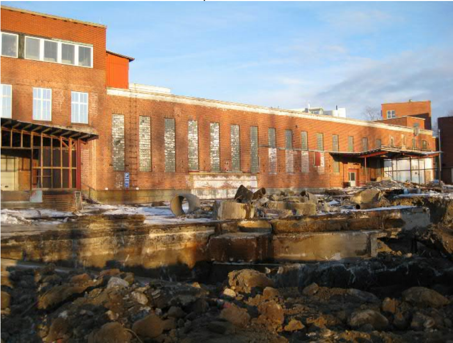
Kuva 3 Maanalaisten rakenteiden purkua
