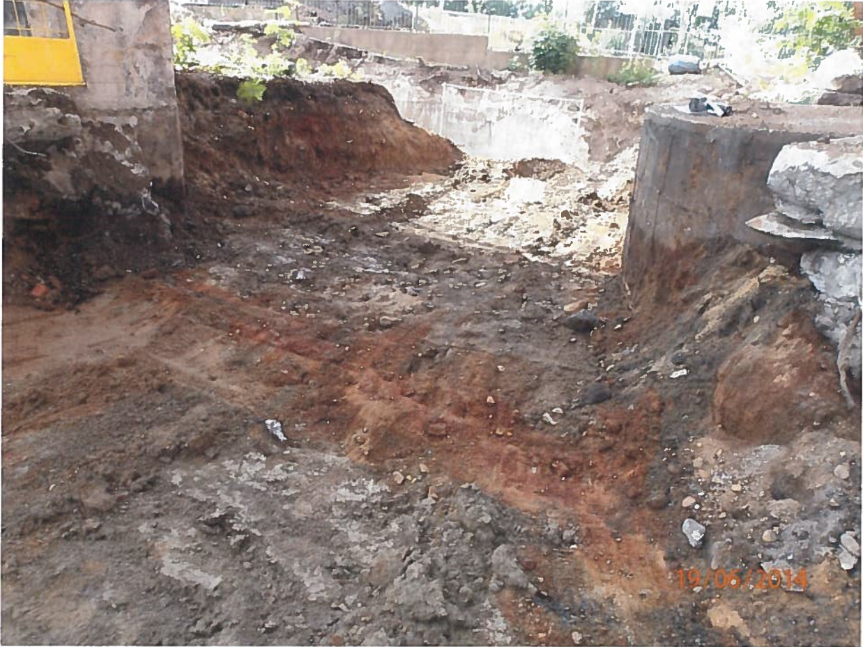
7 RF2 kunnostus. Värjäntynyt maa-aines oli raskasmetalleilla pilaantunutta
