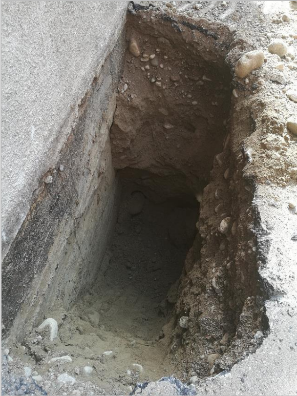
Kuva 4. KK3 tehtiin maksimisyvyyteen, reilu 2 metriä. Ei tavoitettu anturan alapintaa.
