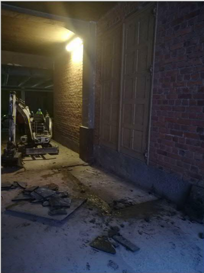
Kuva 8. KK5 asfaltin alla 10 cm paksu betonirakenne, jonka alla maa.
