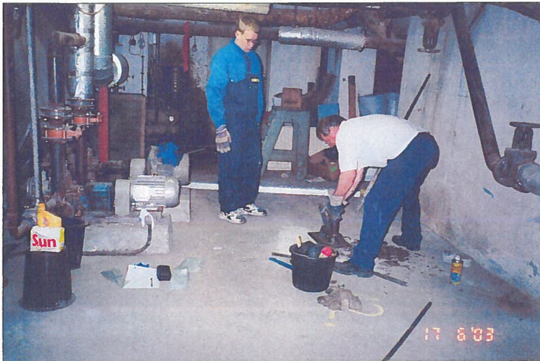
Kuva 10. Tutkimuspiste S34 voimalaitoksen kellarissa.
