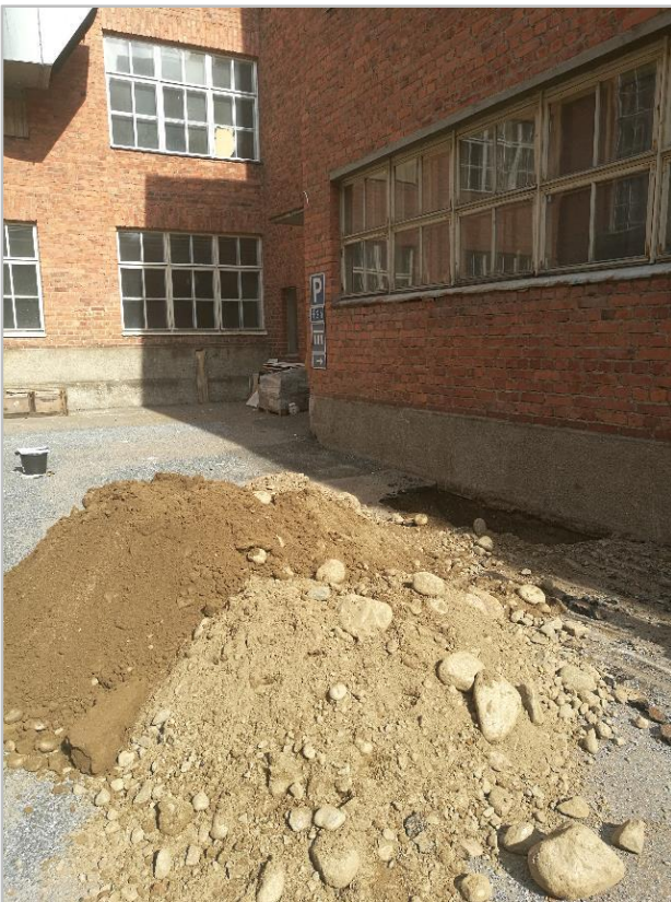
Kuva 5. KK3 maa-aines täyttömaata, mutta ei viitteitä pilaantuneisuudesta.
